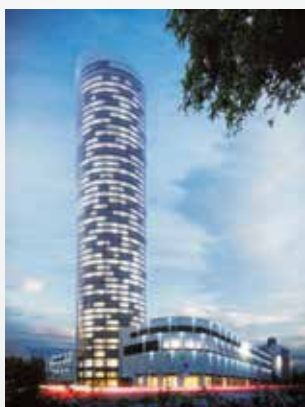
Fot. 36 Wieżowiec Sky Tower, Wrocław
